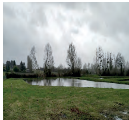
Bassins de lagunage des eaux usées
