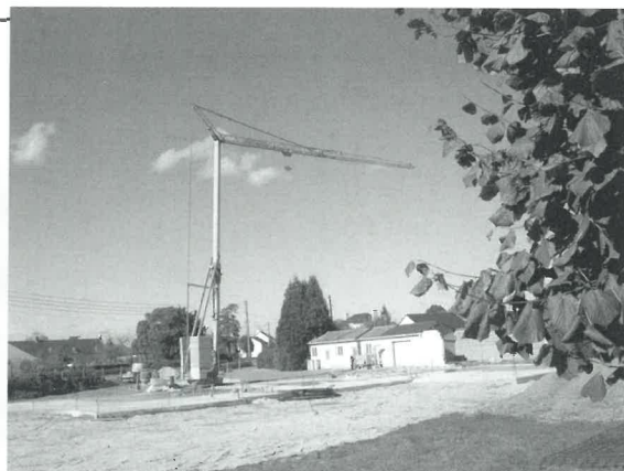
Début des travaux le 10 octobre 2005
