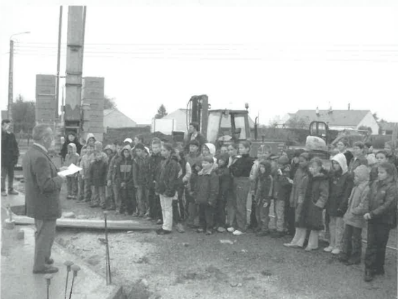
Pose de la première pierre
