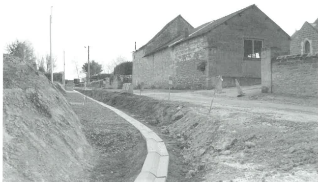
Pendant les travaux en février 2005
