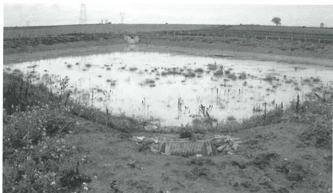
Bassin de rétention réalisé en avril 2005
