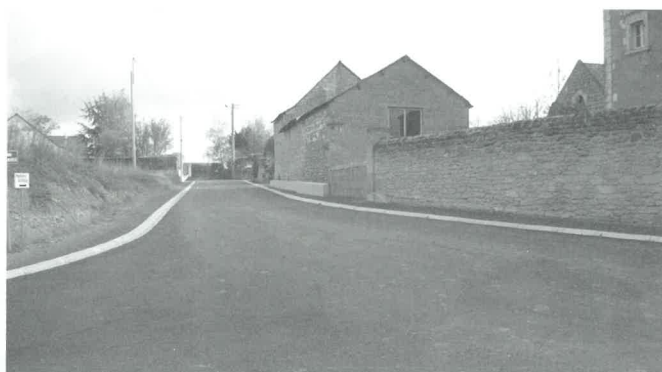
La rue des caves après les travaux
