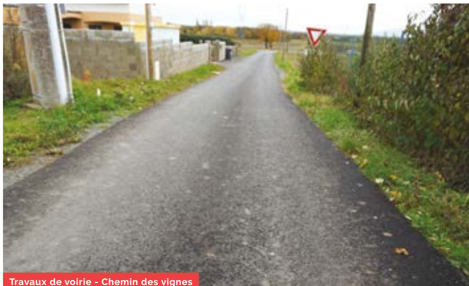
Travaux de voirie - Chemin des vignes
