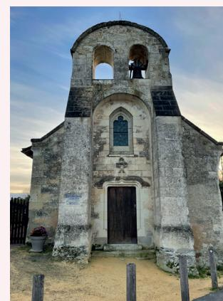
Par ailleurs, comme pour de nombreux édifices anciens, le rapport préconise la mise en place d'un **système de drainage** le long de la façade nord afin de traiter **l'humidité par capillarité** affectant les soubassements de maçonnerie.
