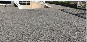
La surface de cet enrobé est entièrement composée de granulats et de liant. Il n'y a quasiment aucun sable. Il permet à l'eau de s'infiltrer.
