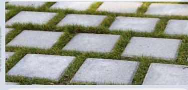
Ce revêtement est composé de pavés avec des joints perméables enherbés. Il permet à l'eau de s'infiltrer.
