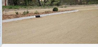
Ce revêtement est composé d'une couche de sable compacté. Il est imperméable et poussiéreux (pulvérulents).
