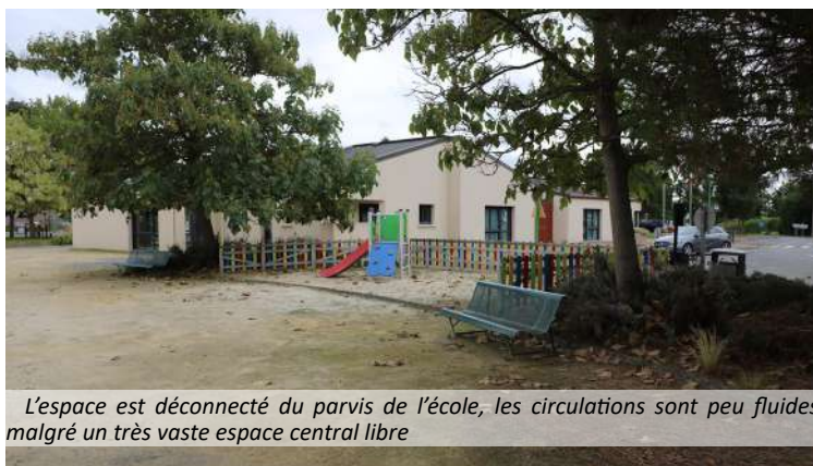
Les aires de jeux se situent sur le pourtour de l'espace, le mobilier en place est en mauvais état
